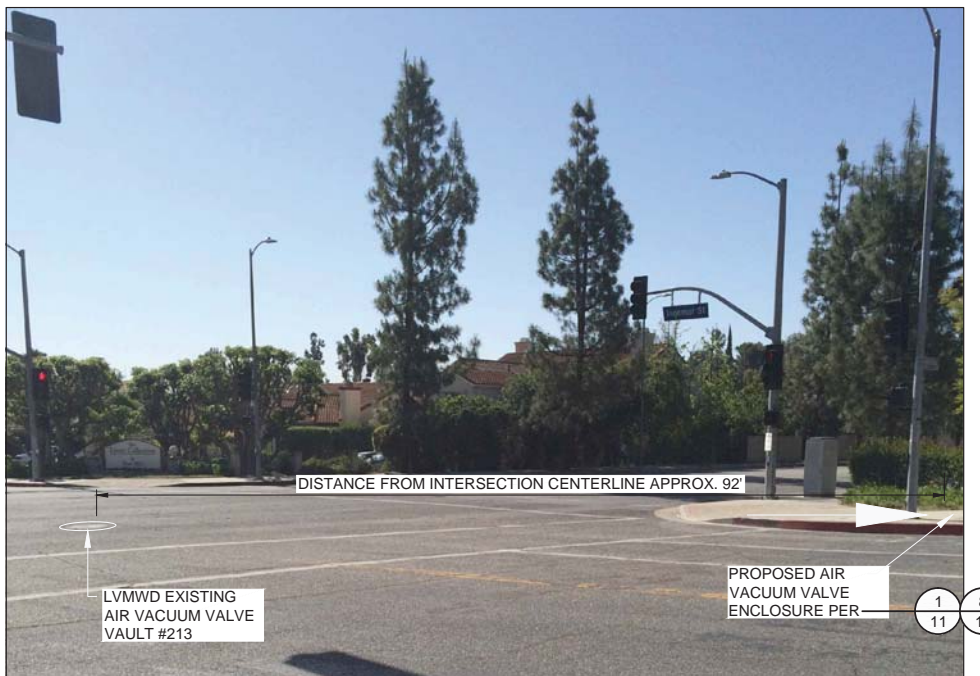
AIR VAC # 213 SITE PHOTO SCALE: N.T.S.
