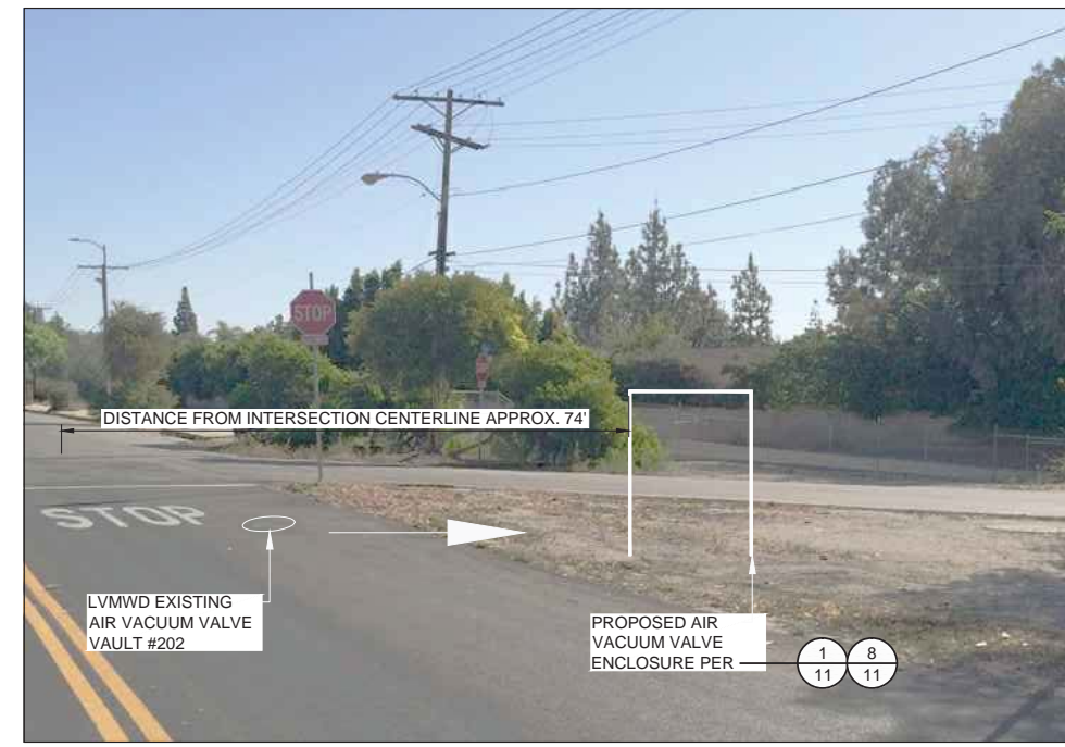
AIR VAC # 202 SITE PHOTO SCALE: N.T.S.
